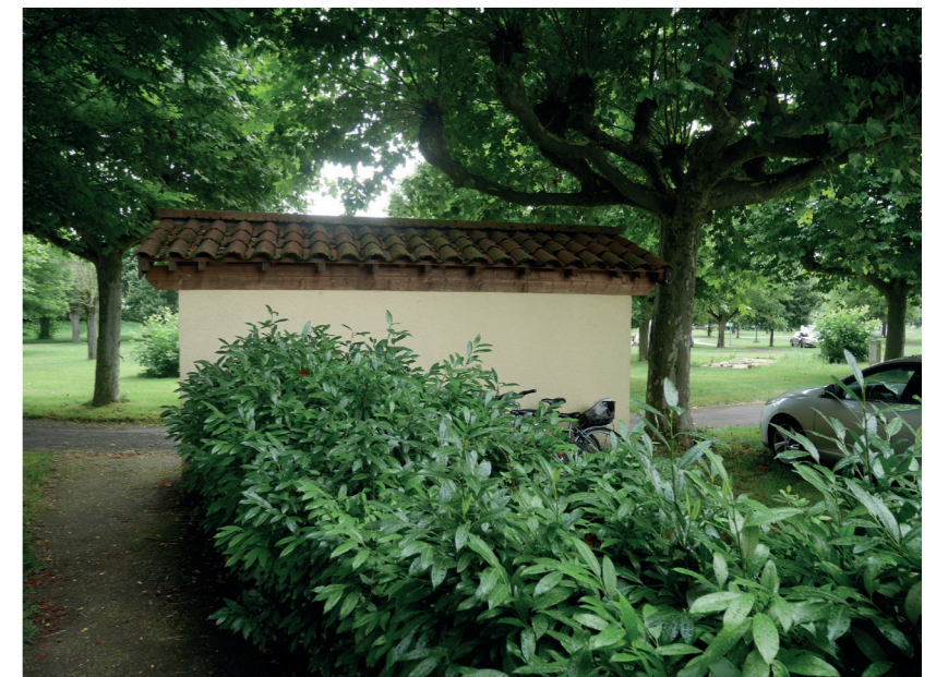
Photos de l'abri à démolir
